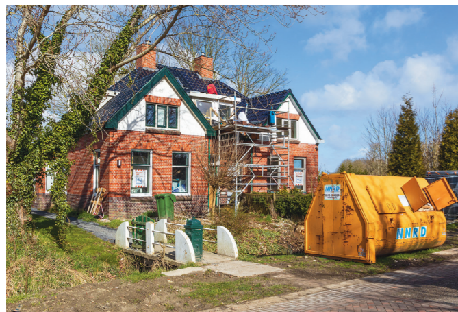
Versterkingswerkzaamheden bij woningen Rijksweg
